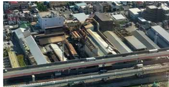
綾瀬工場全景
