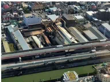
綾瀬工場全景
