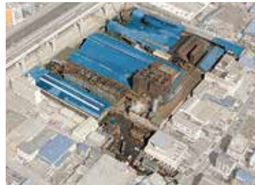
綾瀬工場全景
