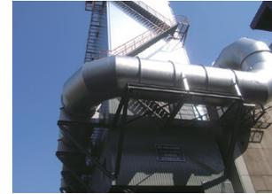
都市型電気炉メーカーとして最新の集塵機（上）を設置し大気汚染を防ぐ。周辺住宅への騒音、振動、臭気対策なども徹底しており、消臭設備（右）なども積極導入している
